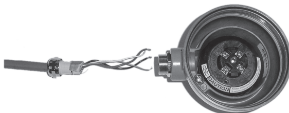
Kuva 3-9: Läpiviennin rungon asentaminen
