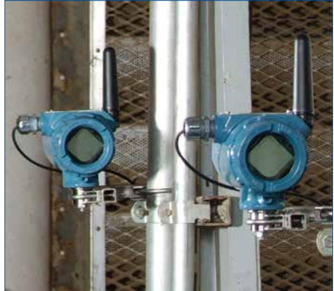
Ein CSI 9420 ist leicht in ein bestehendes Drahtlos Netzwerk einzubinden.
