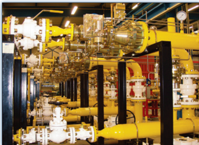
Poste de Détente avec Régulateur FL
