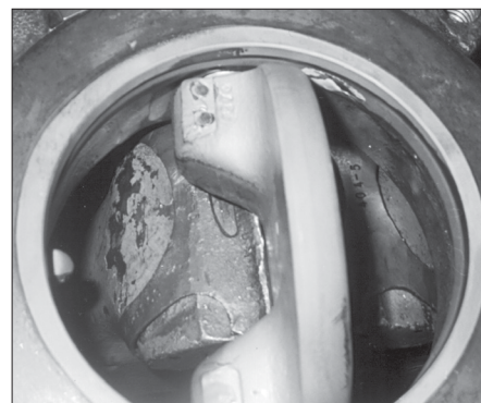
Figure 1 - Robinet correctement serré en place.
