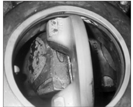
Figure 1 - Robinet correctement serré en place.
