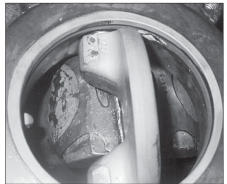
Figura 1 - Valvola fissata correttamente in posizione con i morsetti.
