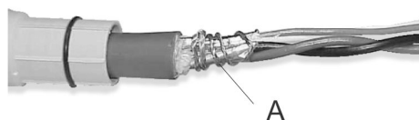
A. Hilos de drenaje enrollados alrededor de la pantalla
