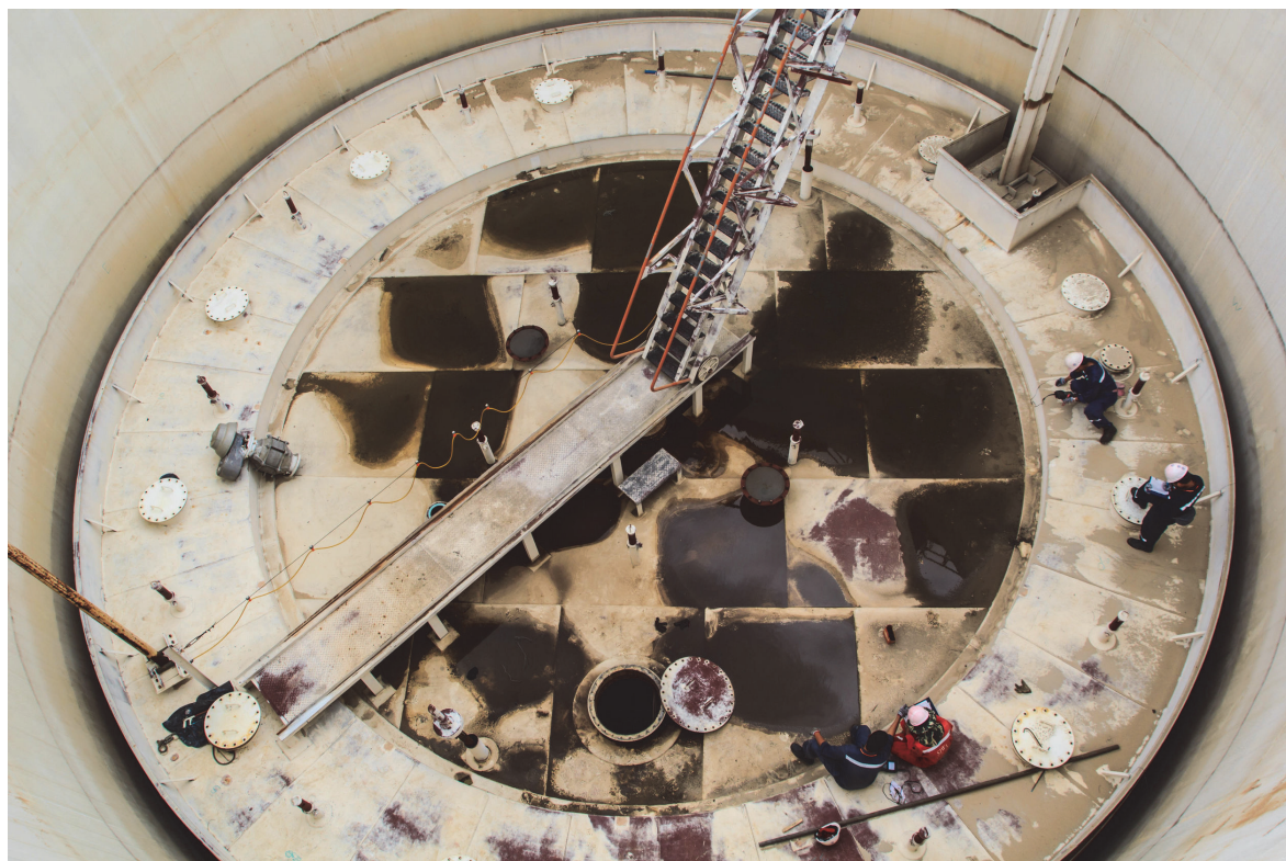
Figure 1-2. Inspection et maintenance d'un toit flottant.
