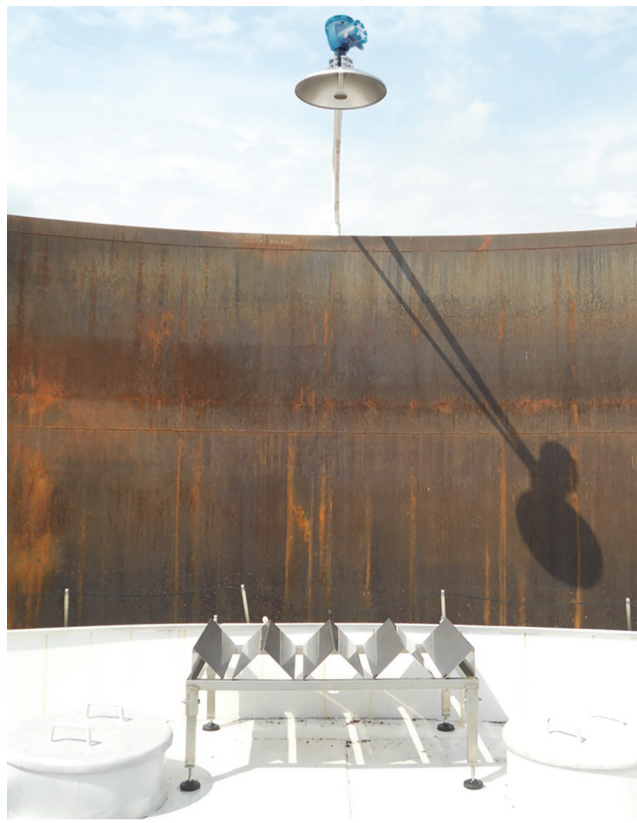
Figure 1-6. Surveillance de toit flottant avec jauge de niveau radar Rosemount 5900C.
