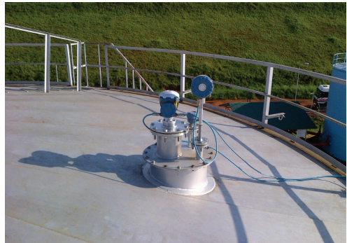
Figure 3.4 : Les trous d'homme sont normalement situés près de la paroi du bac, ce qui assure une stabilité mécanique.
