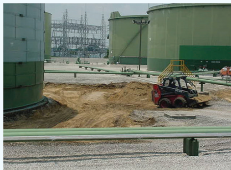
Figure 10.2 : Nettoyage des déversements dans le Massachusetts occidental.
