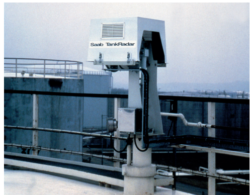
Figure 2.9 : Première jauge radar de haute précision installée en 1985 sur un bac de raffinerie.
