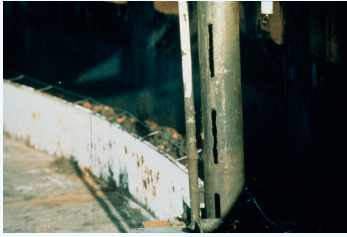
Figure 2.16 : Le mode Faible perte de mesure radar peut être utilisé pour éliminer pratiquement toute dégradation de la mesure dans les anciens puits de tranquillisation.
