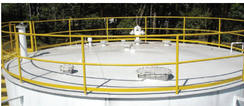
Figure 2.14 : Ouvertures de bac à toit fixe.
