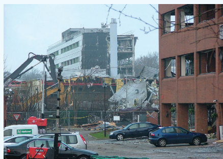
Figure 10.1 : Dommages matériels après l'accident de Buncefield.
