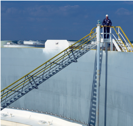
Figure 3.1 : Puits de tranquillisation dans un bac de pétrole brut à toit flottant ouvert.
