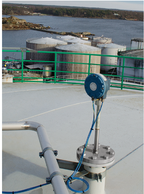
Figure 6.1 : Montage sur la partie supérieure du transmetteur de température avec jusqu'à 16 points de mesure de température.
