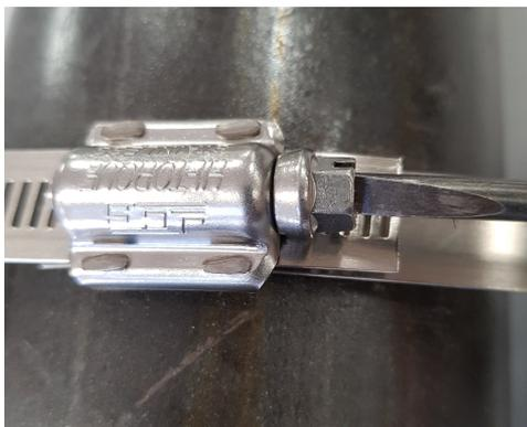
9. Positionner le tendeur de sangle de sorte que la sangle (D) touche simplement la conduite (B) entre le capteur (A) et le tendeur de sangle (C).
