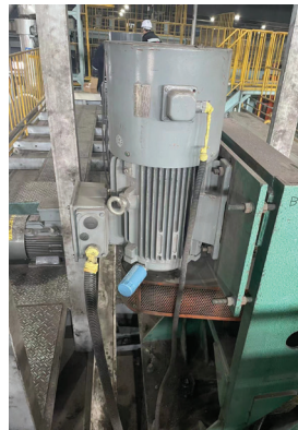
AMS9530无线振动变送器安装示意图
