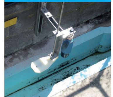
3107 im offenen Kanal
