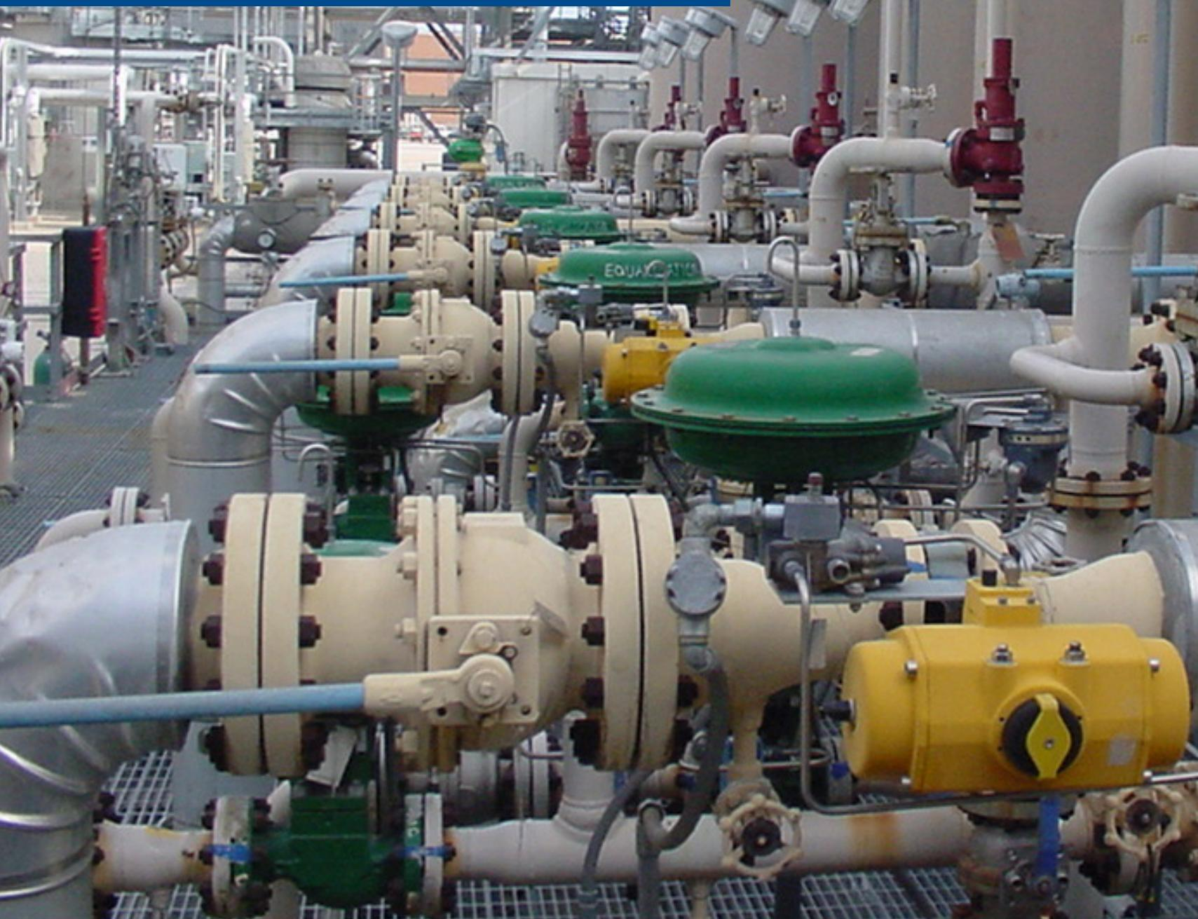
**Система регулирующих клапанов и приводов Fisher™ GX**
