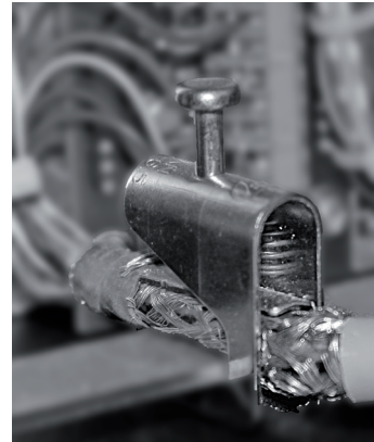
Abb. 2-17: Schirmanschlussklemme mit Kabel
