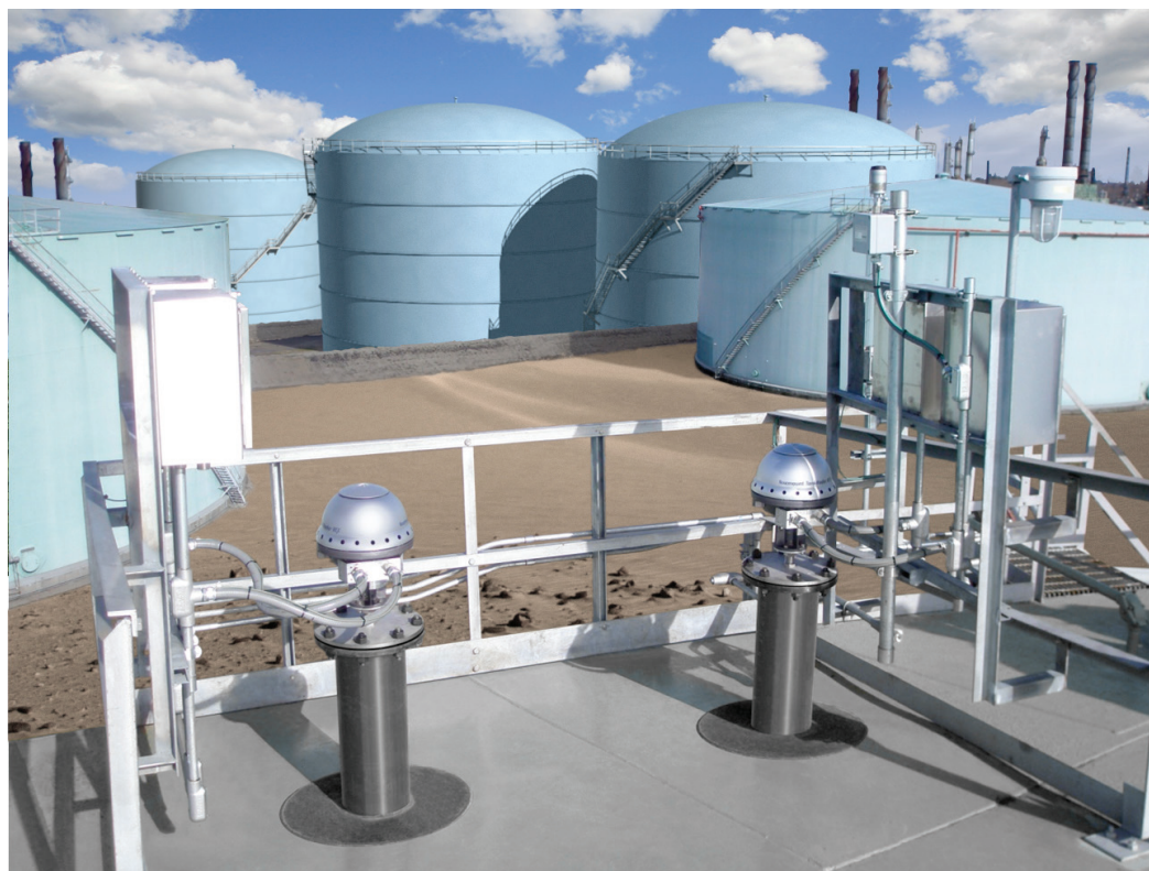
2 ATG per il controllo del livello e la prevenzione della tracimazione. Dispositivi sempre più diffusi man mano che i vecchi livellostati meccanici sono sostituiti da soluzioni moderne
