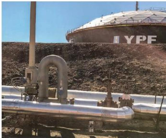
**FIG-4.** Medidores Coriolis localizados na entrada de um tanque óleo cru.
