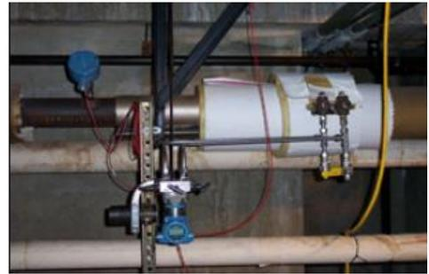
그림2. 3095MFC 콤팩트 오리피스 질량유량계의 다운스트림에 설치된 1495 오리피스 플레이트 (체크미터)
