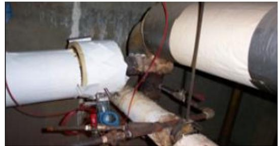
그림1. 각엘보 2개 뒤쪽으로 파이프 직경 2배 거리에 설치된 3095MFC 컨디셔닝 오리피스 질량유량계
