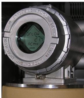
すべての Rosemount 超音波流量計の U.L. 安全認証は、CPU モジュール、電源基板、I.S. バリアボード、バックプレーンボード、オプションの液晶ディスプレイボードを収容する、防爆トランスミッタ電子部筐体を組み合わせることで達成されます。
