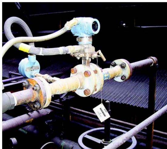
3095MFC コンパクト・オリフィス質量流量計を、90°エルボの下流側の 2D に設置
