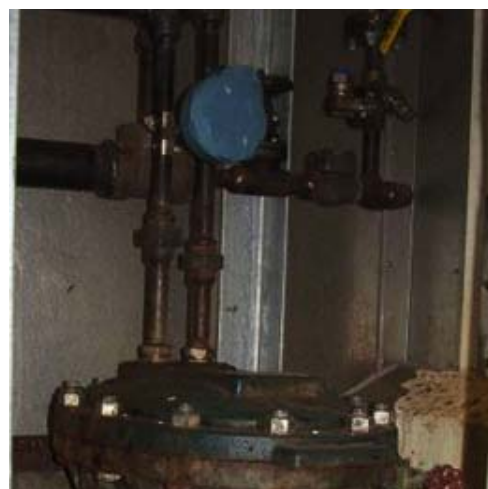
Rosemount 708 ワイヤレス・アコースティック伝送器は、外付けで素早く設置でき、安価で、プロセス非挿入型の一体式センサーが特長です。
