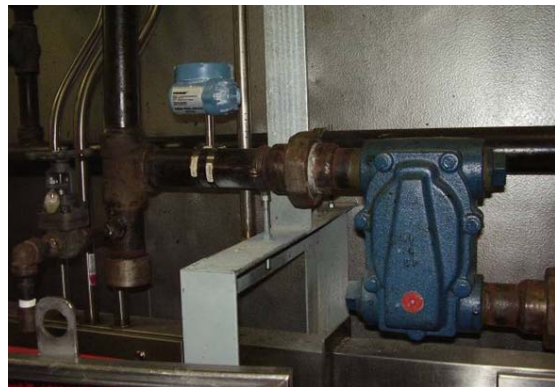
Rosemount 708 ワイヤレス・アコースティック伝送器は、外付けで素早く設置でき、安価で、プロセス非挿入型の一体式センサーが特長です。
