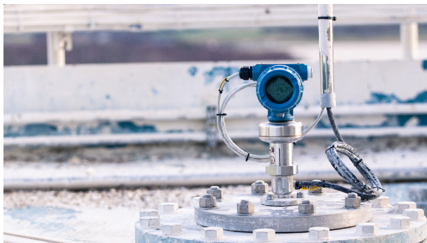
Рисунок 7. Уровнемер 5408, установленный на бункере с известью
