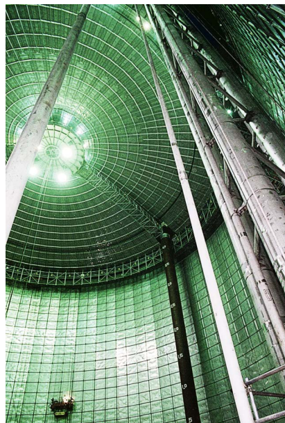
Рисунок 3. Внутри резервуара с двойной оболочкой закрытого типа
