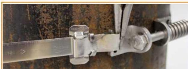
17. Убедитесь, что стропа по-прежнему плоская и расположена на одной линии вокруг трубы, а датчик перпендикулярен трубе. Затем, используя гаечный ключ с храповым механизмом и простой гаечный ключ на концах болта натяжителя, затяните натяжитель до полного сжатия пружины. Между двумя L-образными скобами должен оставаться зазор не менее 1 см.
