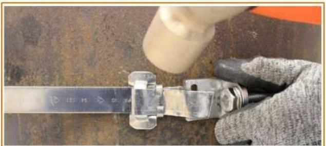
**Примечание.** Обратите внимание, что предварительное сгибание ушек пряжки с помощью плоскогубцев с регулируемым скользящим соединением может уменьшить ударную силу, необходимую для последующего прижатия ушек к стропе.
